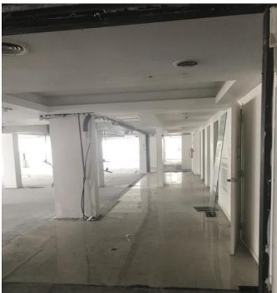
En ambas plantas, el revestimiento del piso del hall se retirará, según se indica en el plano anexo de demolición; así como también la carpeta para poder realizarla nuevamente y colocar el revestimiento requerido por pliego.
