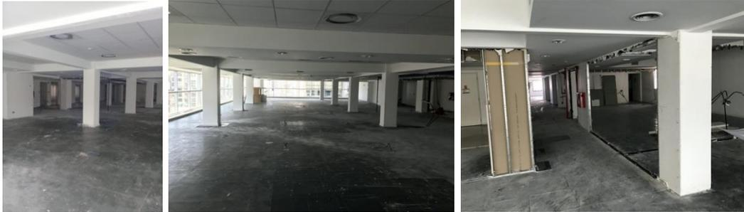
En el piso técnico existente se evidencian agujeros, roturas, levantamiento en varios puntos, e interrupciones entre las placas debido al retiro de tabiques. Se deberá hacer la nivelación del mismo. A su vez se deberán sustituir los elementos que fueran necesarios, así como también las placas deterioradas o defectuosas; realizando así las terminaciones de solados y zócalos según se indica en el pliego de especificaciones técnicas.
