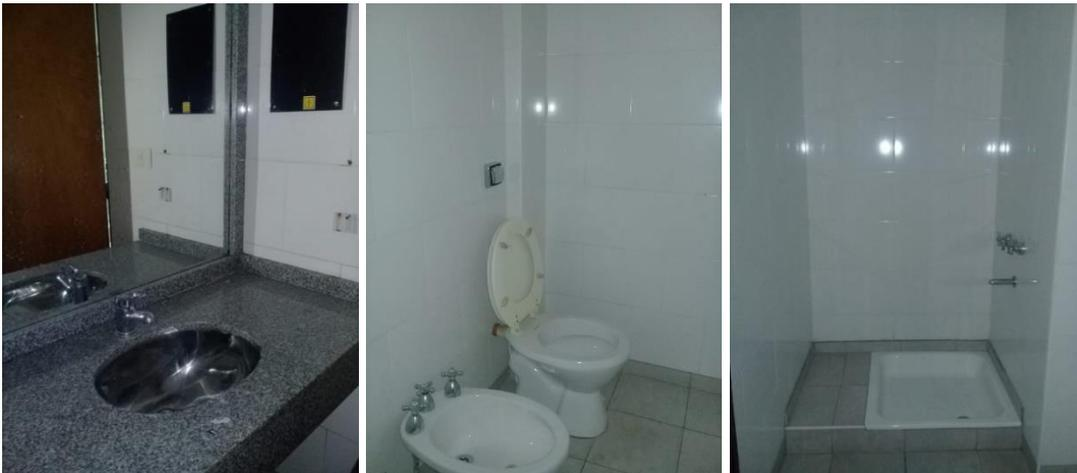
En baños del Sector B se deberá modificar la bacha de lugar que se muestra en las siguientes fotos, por lo que será necesario demoler y reemplazar los revestimientos, pisos y tabiques indicados según especificaciones de pliego y planos.
