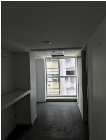
El sector de la planta que según proyecto devendrá en pasillo, deberá ser nivelado con el piso técnico ya que allí se colocará, posteriormente, piso vinílico en listones según se indica en el PET.
