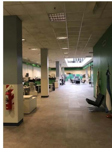
El segundo piso, se divide en 2 áreas principales: en el contrafrente, una nave central de trabajo, cuyo solado es de alfombra sobre carpeta de material, planta libre con columnas estructurales y divisiones de aluminio vidrio y tabiques de placa de roca de yeso existente que, serán modificadas según proyecto. En el sector central se genera un vacío sobre el primer piso.
