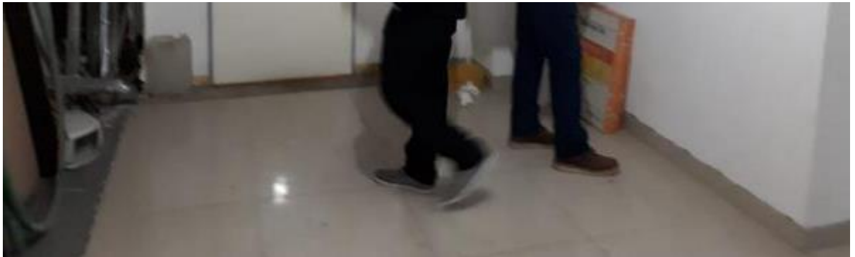
Porcelanato a demoler.
