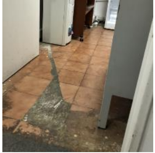
Piso cerámico sin intervención.
