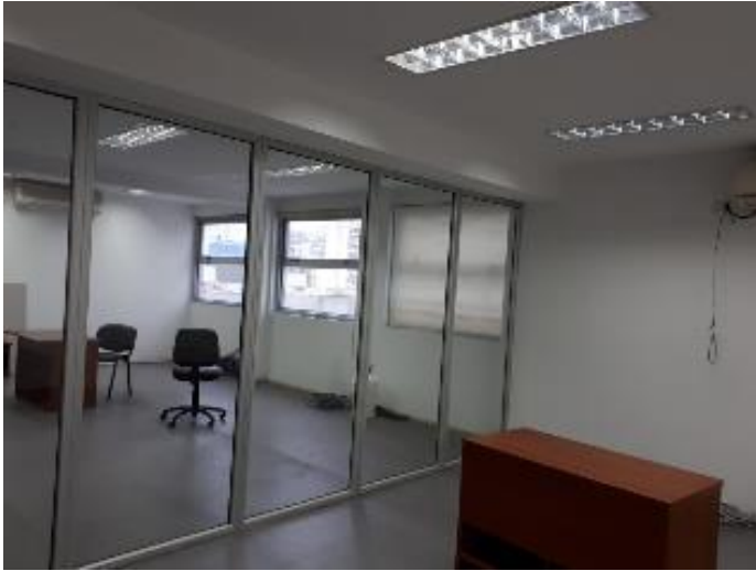
Revestimiento vinílico a retirar.
