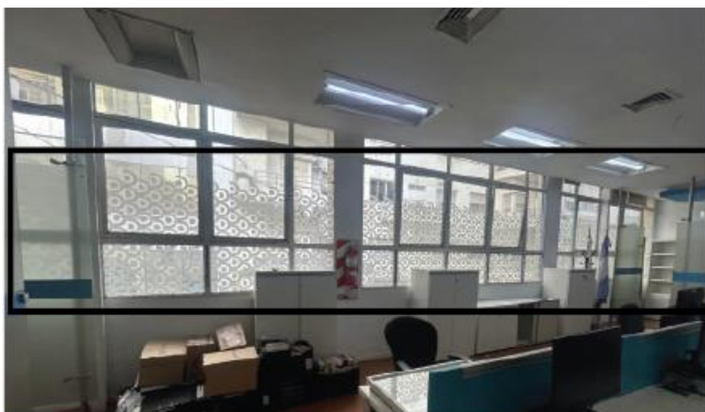
12M X 1.20M SUPERFICI DEL DESMONTAJE DE VINILO DE CORTE ESMERIL SOBRE VIDRIO PEGADO DEL LADO INTERNO. SUP.TOTAL 14.40M2
